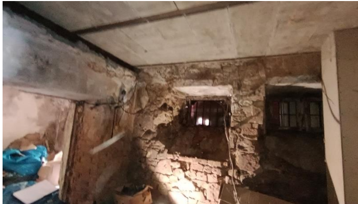
Fot 1. Widoczna ubytki w ścianach
