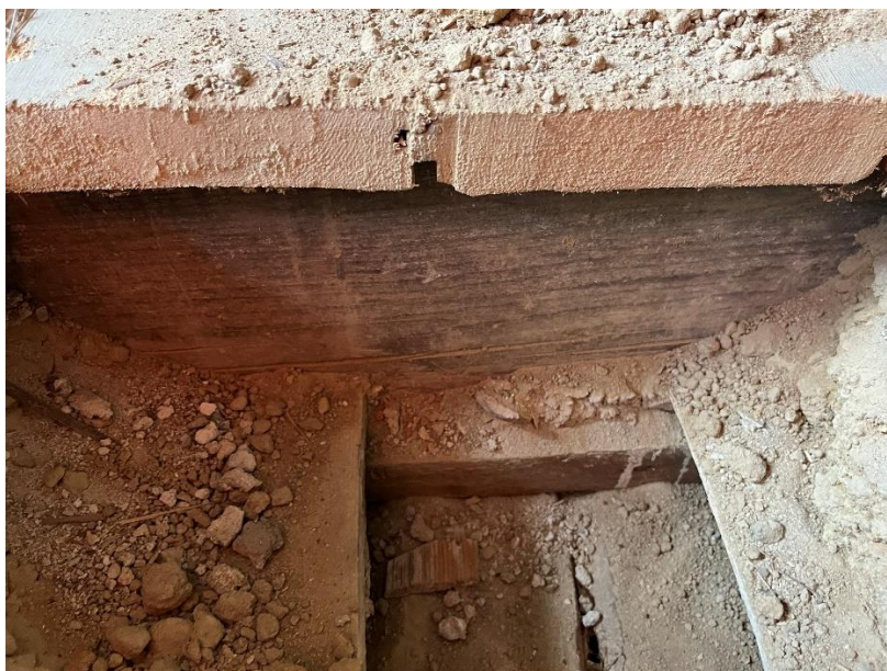
Fot 7. Odkrywka „od góry” pokazująca konstrukcję drewnianą stropu
