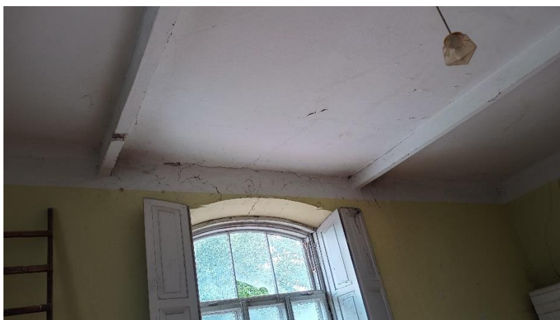
Fot 6. Belka stalowa stropu drewnianego parteru
