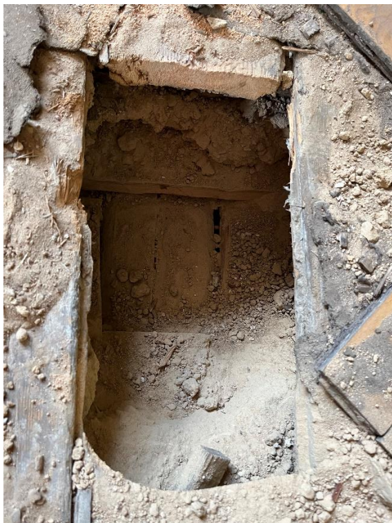
Fot 4. Strop drewniany parteru
